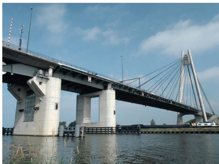
跳開橋と吊橋
